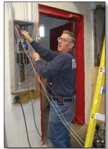
Mike Przybycien pulling wire at Station 7
